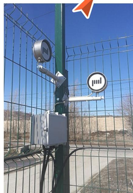
Возможность оперативного изменения угла наклона приемного и передающего блоков позволяют менять форму и свойства зоны обнаружения
